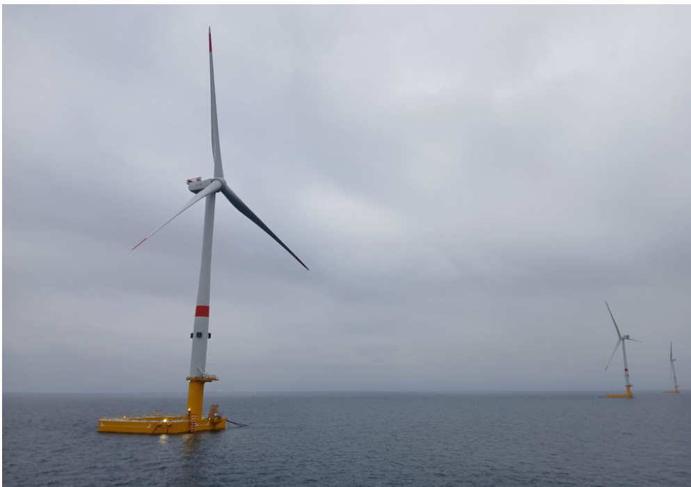
Opération de mise sous tension réalisée ce lundi 20 avril
